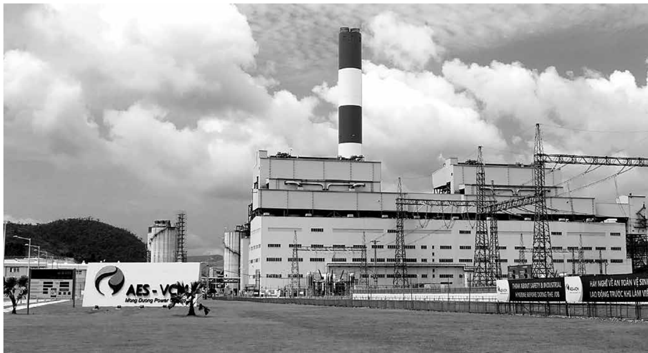
▲ Nhà máy Nhiệt điện Mông Dương II thuộc Công ty TNHH Điện lực AES-TKV Mông Dương đã được chứng nhận quốc tế về quản lý môi trường ISO 45001:2018
