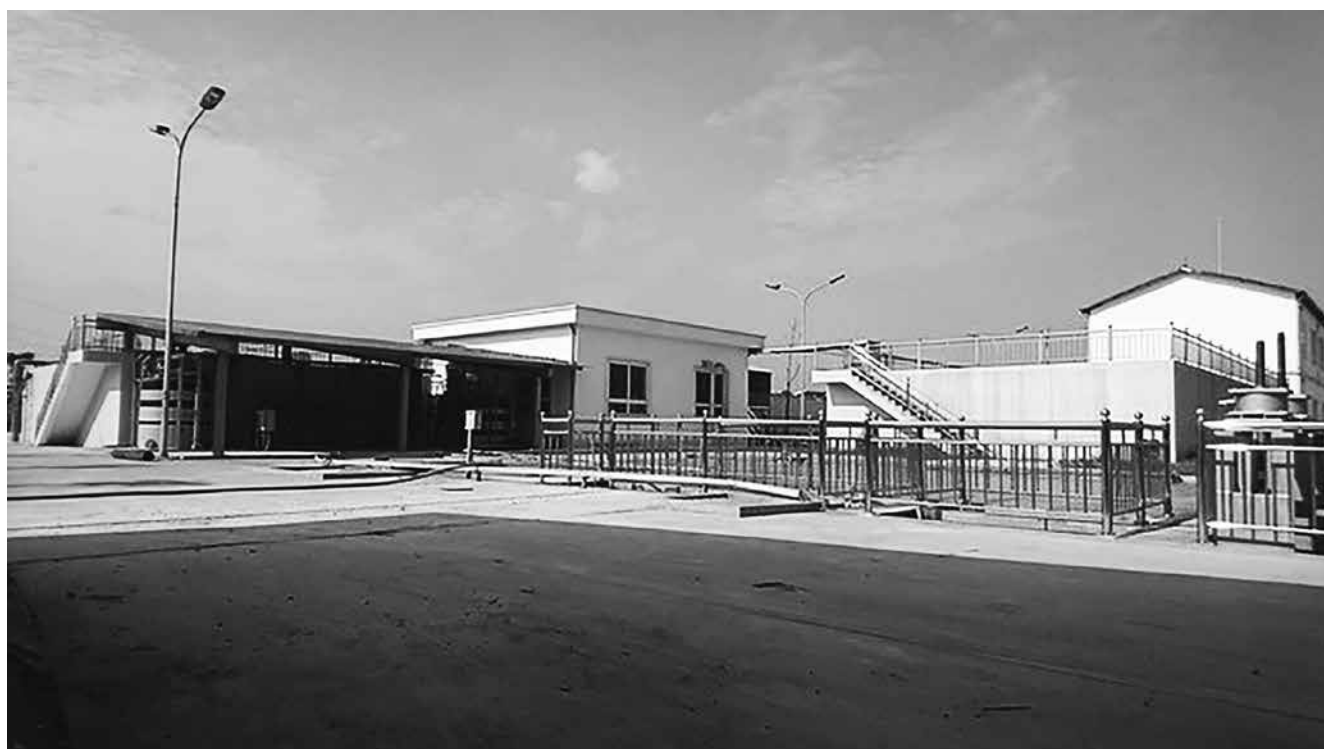
▲ Nhà máy xử lý nước thải Phong Khê (Bắc Ninh)
